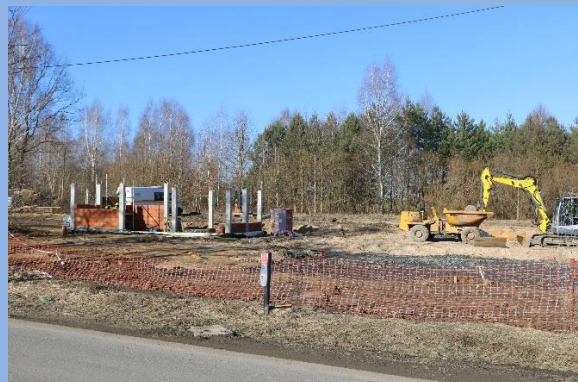
Výstavba prestupného uzla v obci Psary, zdroj: Obec Psary
