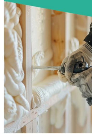
Strecha zateplená penou PUR (polyuretánovou ) / PIR (polyisokyanurátovou))
