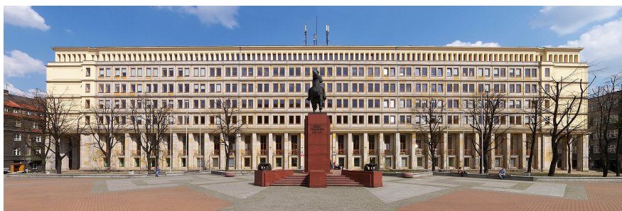
Rysunek 16: Budynek Urzędu Marszałkowskiego w Katowicach, zdjęcie. (Jan Mehlich, GFDL, Creative Commons Attribution ShareAlike 2.5)
