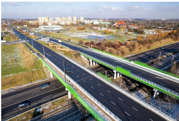
Wiadukt nad DK 88 w Zabrzu, źródło: strona internetowa Urzędu Miejskiego w Zabrzu
