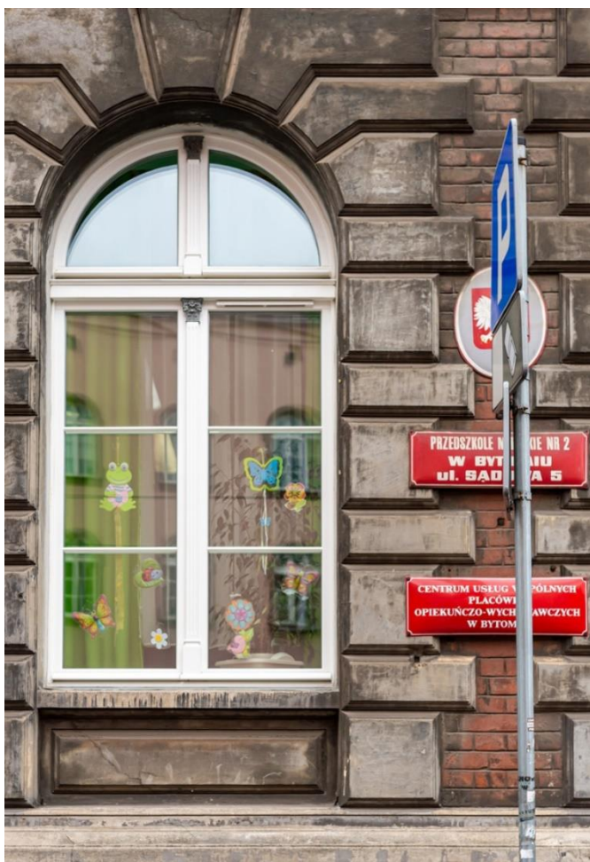
Ilustr. 18 Poprawnie zrekonstruowana stolarka okienna w budynku przy ul. Sądowej 5 w Bytomiu
