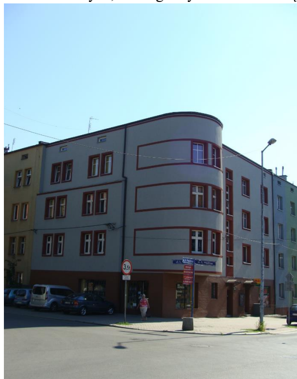
Ilustr. 1 Bytom, budynek przy ul. Pułaskiego 24 po pracach dociepleniowych utrzymany w estetyce kiczu. Nie odtworzono kolorystyki, gzymsów, obramień okiennych, usunięto maszt. Budynek stracił wszystkie walory zabytkowe, a jego estetyka jest wyjątkowo niekorzystna
