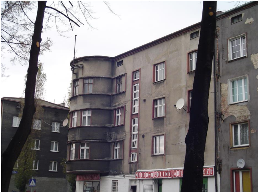
Ilustr. 2 Bytom, budynek przy ul. Pułaskiego 24 przed termomodernizacją. Uwidaczniają się gładka powierzchnia tynku, glazurowane obramienia okienne, gzymsy w zaokrąglonym wykuszu nadające dynamikę temu elementowi elewacyjnemu, z kolei zwieńczeniem był modernistyczny maszt upodobniający obiekt
