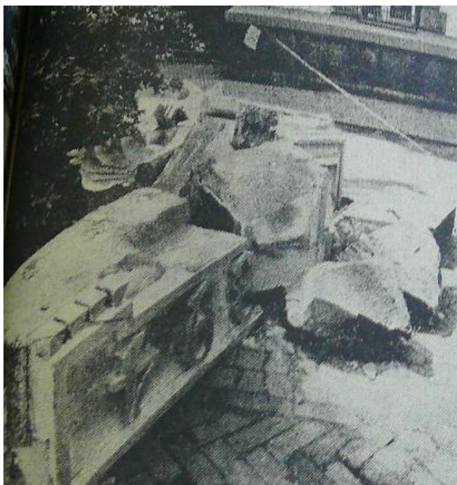
Ilustr. 8 Tąpnięcie z 4 czerwca 1982 r. z godz. 12.44. Fragment gazety miejskiej "Życie Bytomskie". W wyniku tąpnięcia z wielu elewacji spadły naczółki i inne formy dekoracyjne. Na fotografii przedstawiono dekoracje, które spadły z sądu rejonowego
