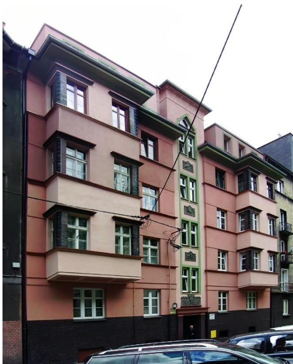
Ilustr. 34 kamienica przy ul. Estreichera 5 w Bytomiu
