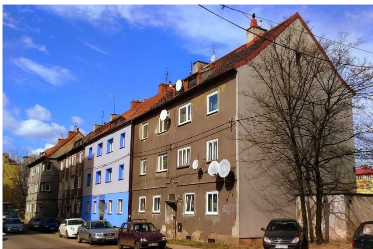
Ilustr. 29 zabudowa funkcjonalistyczna z elementami art deco z dekoracją (dawniej) kontynuowaną w granicach całego układu przy ul. Gallusa 1-5 w Bytomiu
