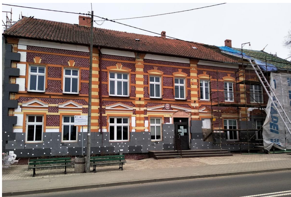
Ilustr. 7 prowadzone docieplenie budynku gminy w Baniach Mazurskich (budynek nie podlega zgłoszeniu, gdyż nie przekracza 12 m)
