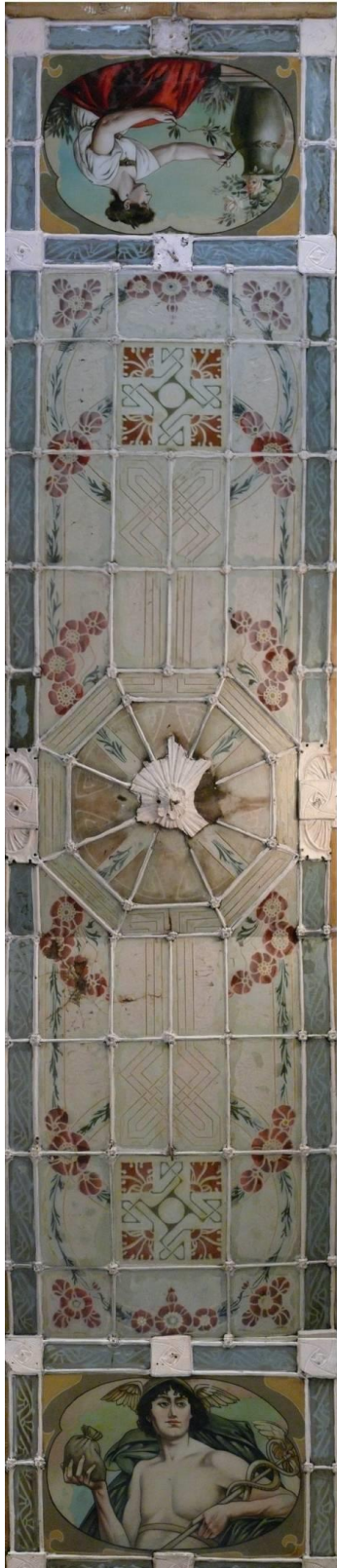
Ilustr. 15 sufit kamienicy przy ul. Jainty 15 w Bytomiu.
