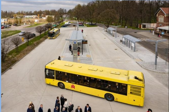
Transfer hub at Parkowa Street in Świerklaniec, source: transport-publiczny.pl
