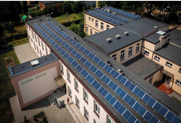
Fotovoltaická inštalácia v Świerklanci, zdroj: Všeobecný úrad Świerklaniec
