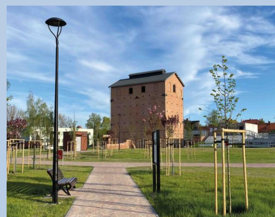
Bývalá koksáreň Orzegów, zdroj: Mestský úrad Ruda Śląska
