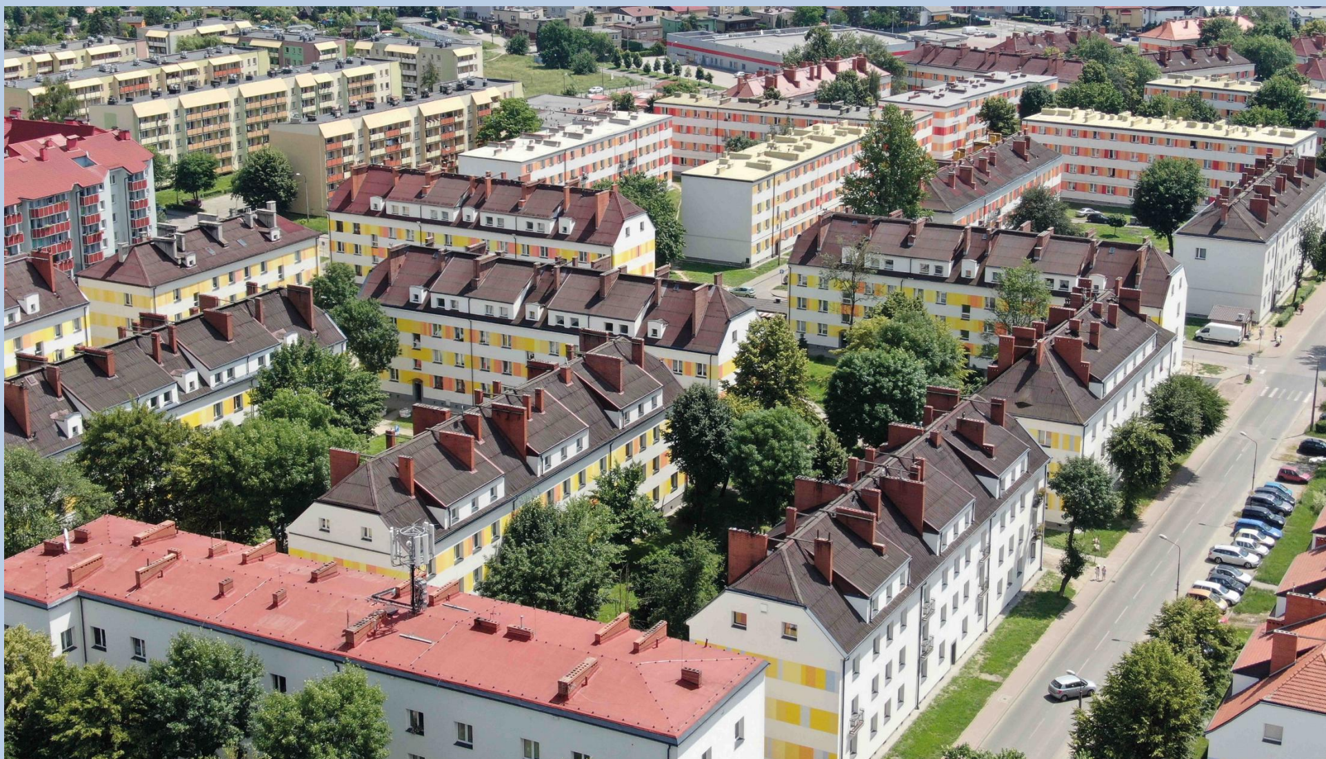
Připojení budov k dálkovému vytápění a tepelná modernizace v Piekarách Śląskich, zdroj: Městský úřad v Piekarách Śląskich
