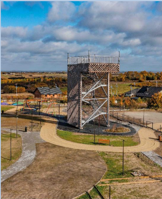
Vzdělávací centrum Góra Siewierska, zdroj: Úřad obce Psary
