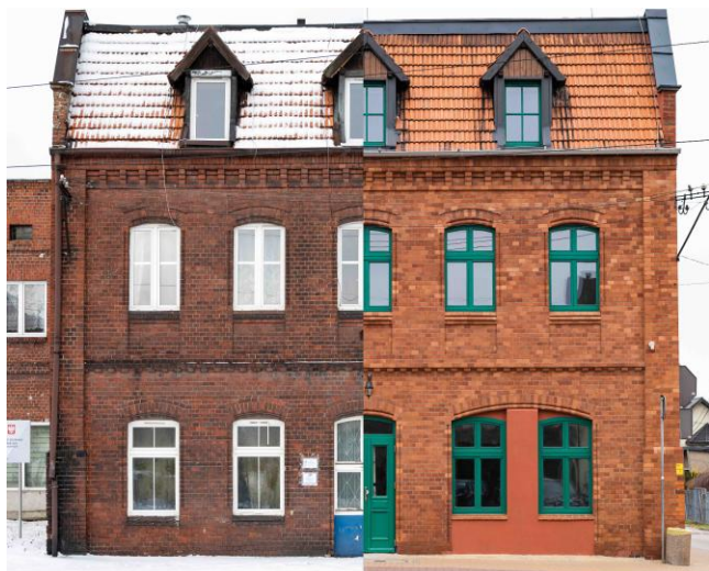
Tepelná modernizace historické budovy v Tychách, zdroj: Městský úřad pro bytovou výstavbu v Tychách
